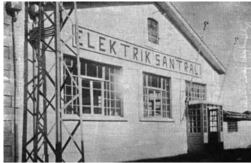
Görsel 19: Elektrik santralinden görünüm.
