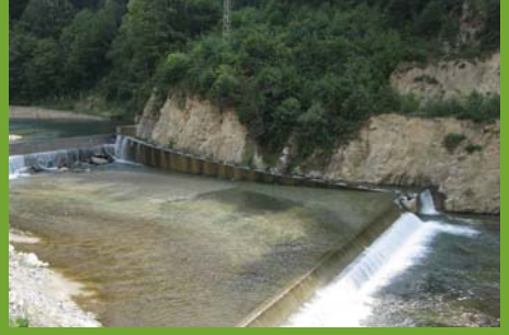
Dereye bırakılan su üzerinde her ne kadar balık geçidi inşa edilmişse de, nehir üzerine beton dökülerek düzleştirme yapılmıştır ve balık geçidini kullanabilen balıklar haricinde diğer canlıların nehir içinde ileri-geri hareketi kesintiye uğramıştır. (Ikdere Vadisi, Rize)
