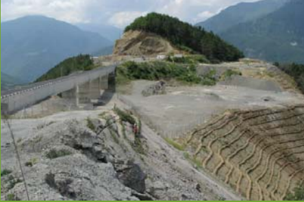
HES inşaatı nedeniyle üst toprak katmanı sıyrılmıştır. (Çoruh Vadisi, Artvin)
