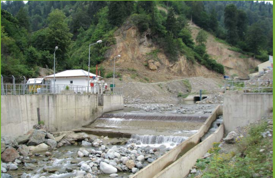
Dere yatağına "can suyu" adı altında bırakılan su miktarı yetersizdir. Nehrin doğal yapısı ciddi boyutta değişmiş ve sucul canlıların sağlıklı yaşamı olanaksız hale gelmiştir. (Kabaca Vadisi, Artvin)
