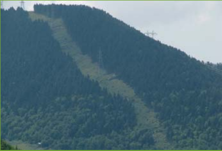
Elektrik iletim hatları kurulurken yapılan tıraşlama işlemleri orman alanlarını tahrip eder. (Çoruh Vadisi, Artvin)
